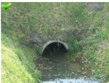
Talud gemaaid en de sloot schoon.
